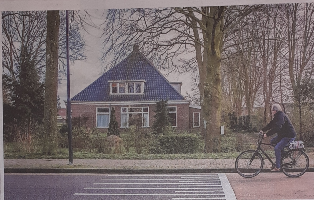
De boerderij aan de Jousterweg wordt gesloopt als het nieuwbouwplan gerealiseerd wordt.
